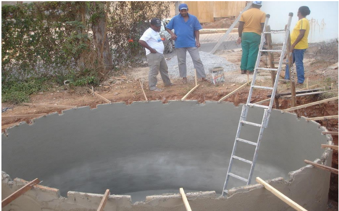
Figura 1 – Cisterna de alvenaria em construção
