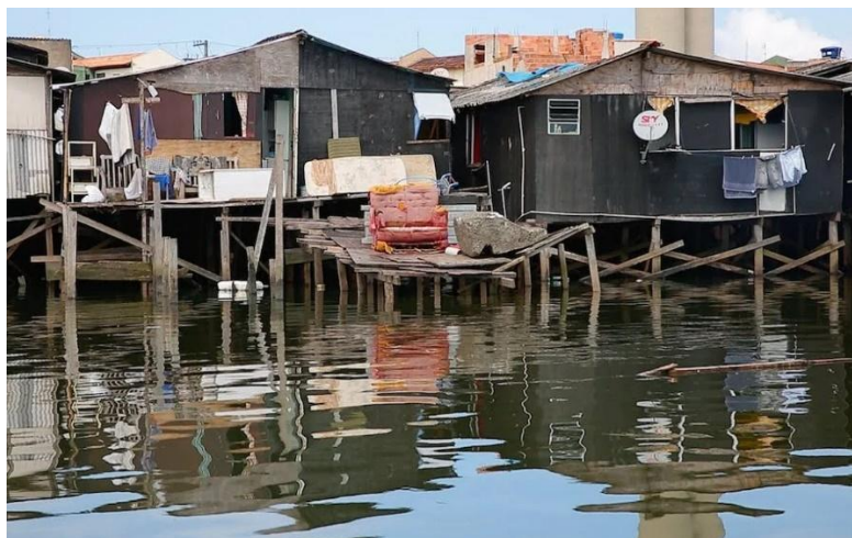
FIGURA 4 – Casebres das palafitas do Dique da Vila Gilda, em Santos-SP.
