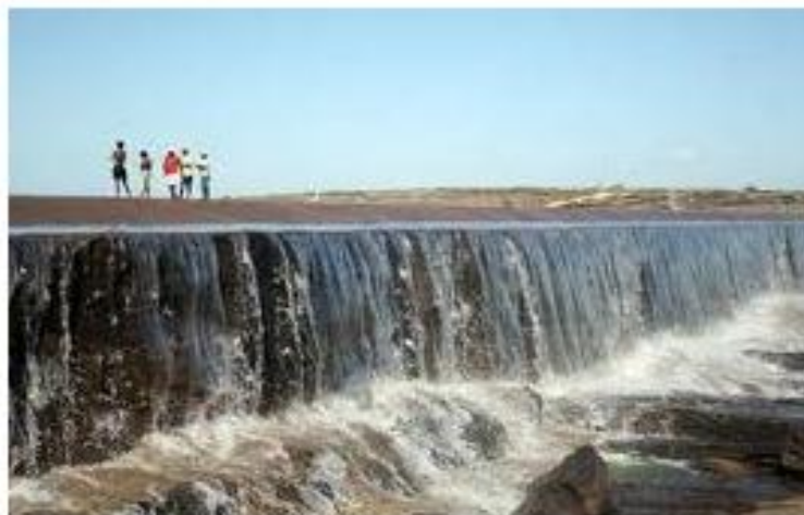
Figura 58 – Parede interna da barragem Fonte: Site Itaja Acontece.
