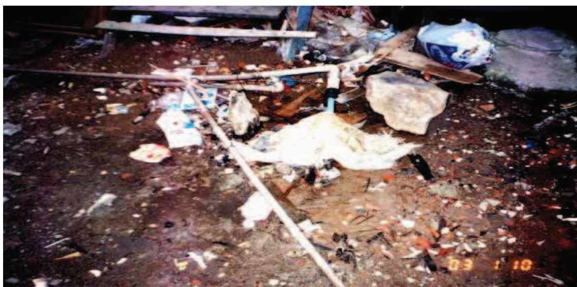
Foto 4: Ligações de água: vários canos no mesmo hidrômetro
