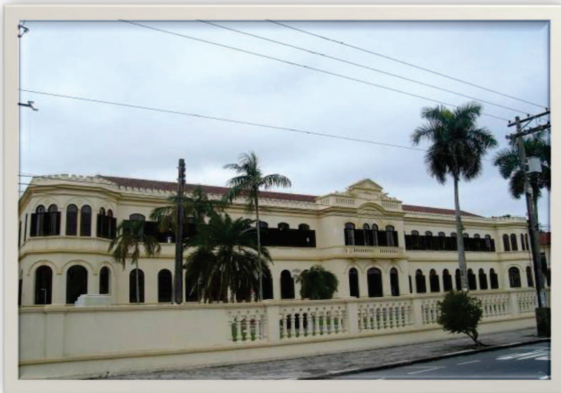
FOTO 4 - Vista externa do prédio do Museu de Pesca – Fonte: http://www.novomilenio.inf.br/santos/h0262b.htm
