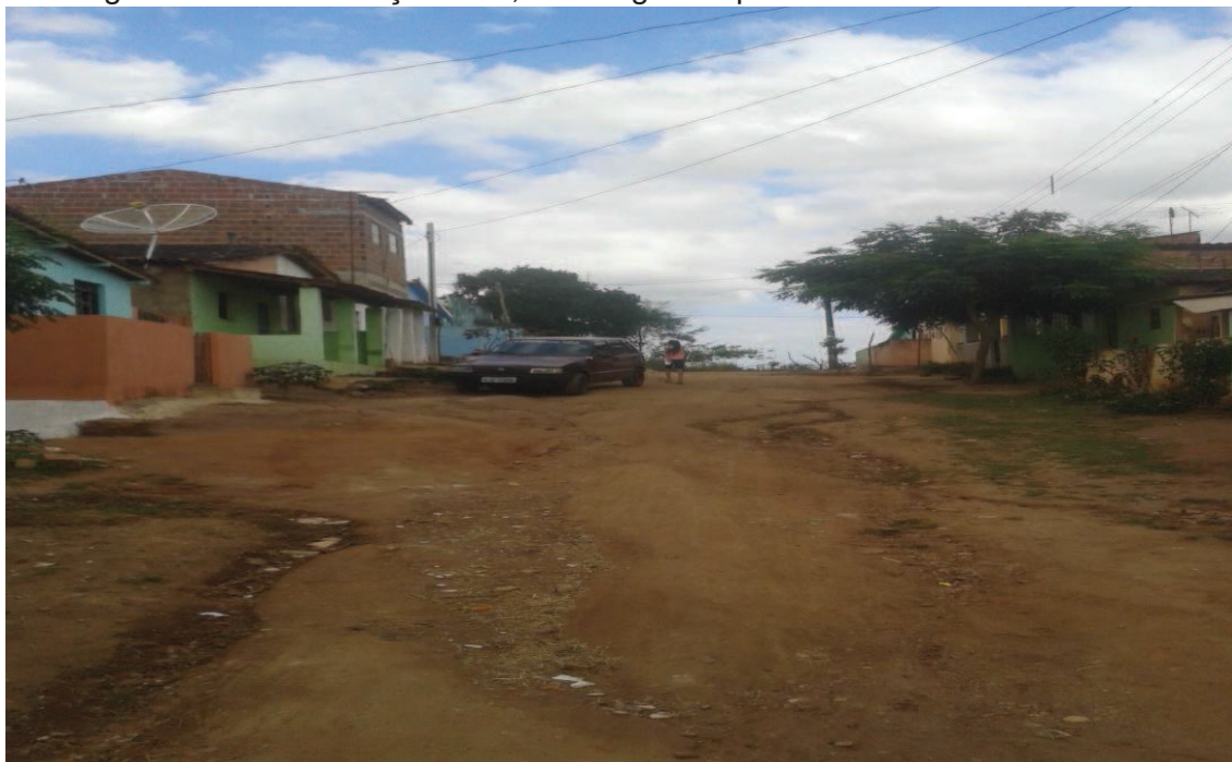
Imagem 2: Rua sem calçamento, com esgoto exposto.
