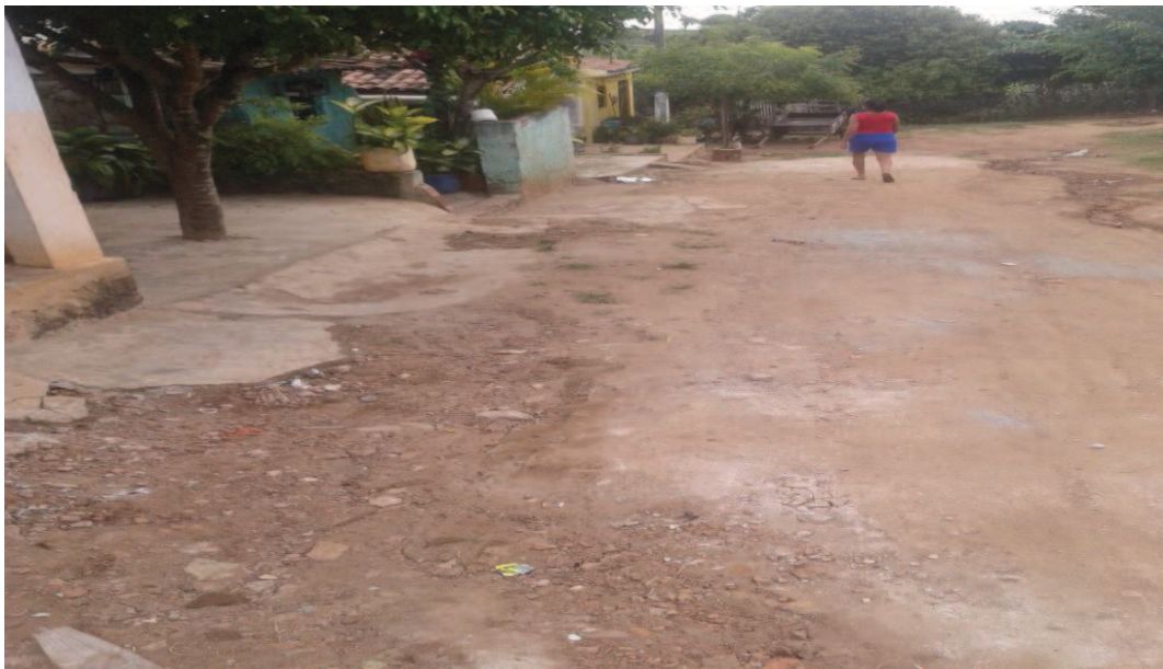
Imagem 1: Rua sem calçamento, com esgoto exposto.
