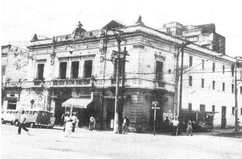
A arquitetura do Teatro Guarany baseia-se no estilo da época, eclético do final do século XIX, construído com paredes em alvenaria de pedra, executado com tesouras em estrutura de aço recoberto com telhas de barro tipo francesa<sup>181</sup>, destacando-se pinturas de Benedito Calixto que detalhou no teto do Teatro o romance chamado “O Guarany”, escrito por José de Alencar.
