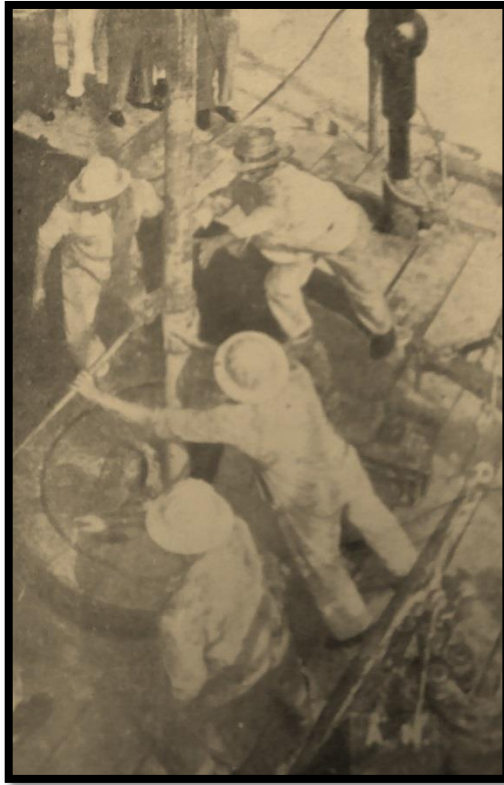
Figura 31: Trabalhadores brasileiros na perfuração do subsolo, em Lobato, na Bahia. Fonte: retirado da obra O Problema Brasileiro do Petróleo (ALVES, 1954)
