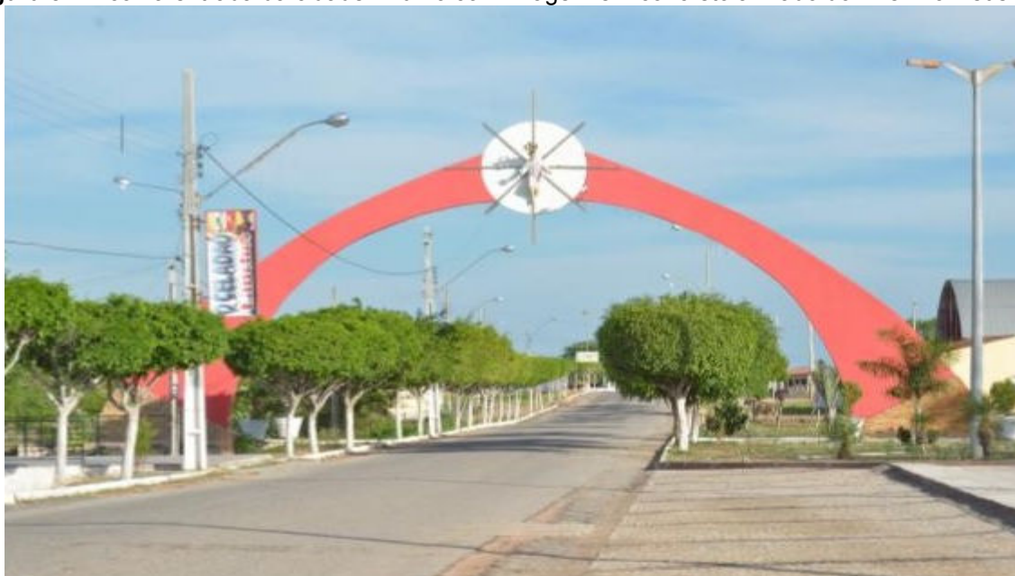
Figura 5 - Arco na entrada da cidade Triunfo com imagem em concreto armado do “Menino Deus”.
