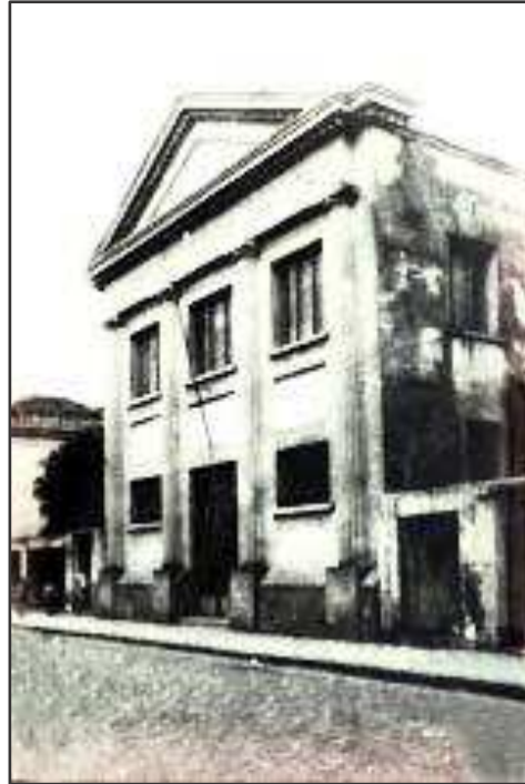
Figura 10 - Prédio construído pela AFS à rua da Constituição, 321
