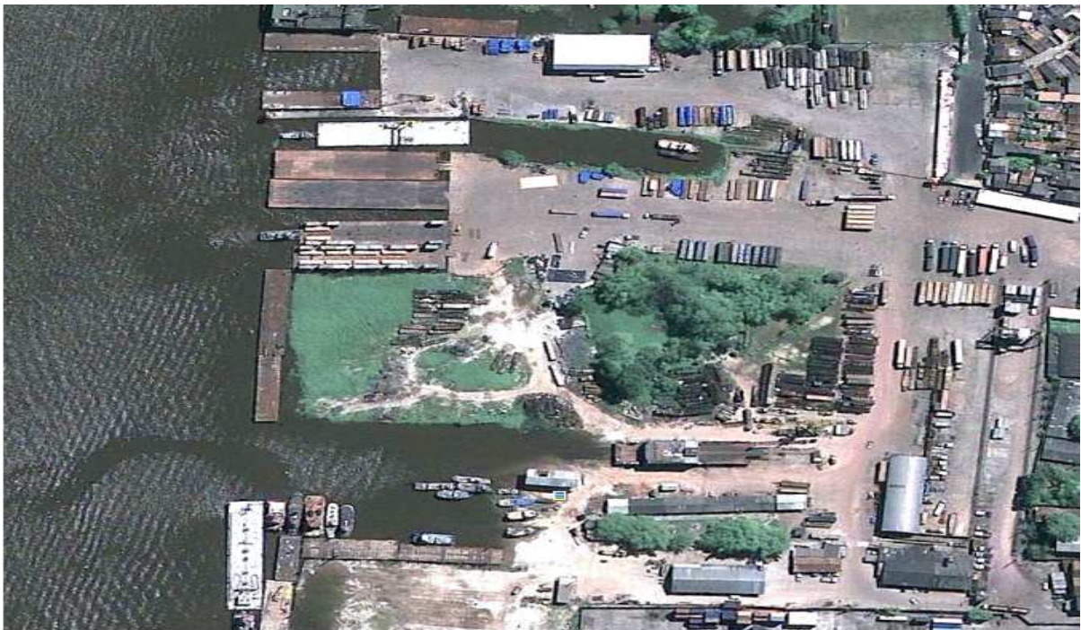
Figura 9: Terminal portuário para balsas em Belém – PA Fonte: Google Earth (2010).
