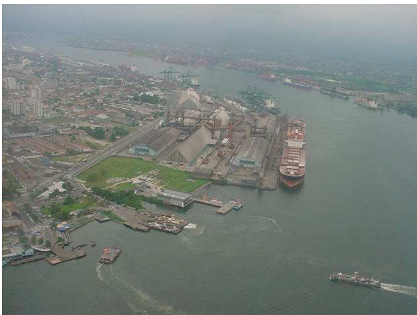
Imagem 12. Vista aérea dos armazéns que formam o Corredor de Exportação, na Ponta da Praia.
