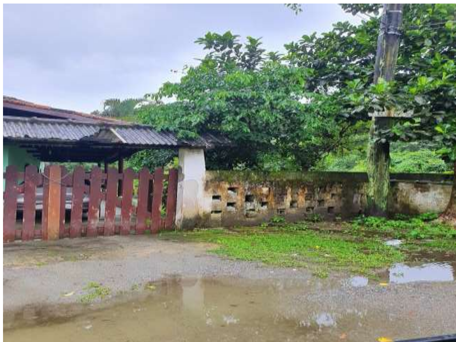
FIGURA 8. Ocupação em margem de curso d'água na Rua Tupy.
