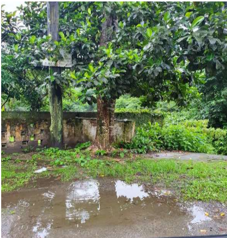
FIGURA 20. Construção em margem de curso d'água (Rua Tupy).
