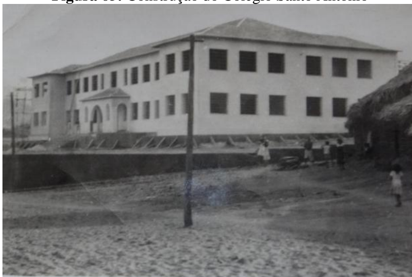
Figura 65: Construção do Colégio Santo Antônio
