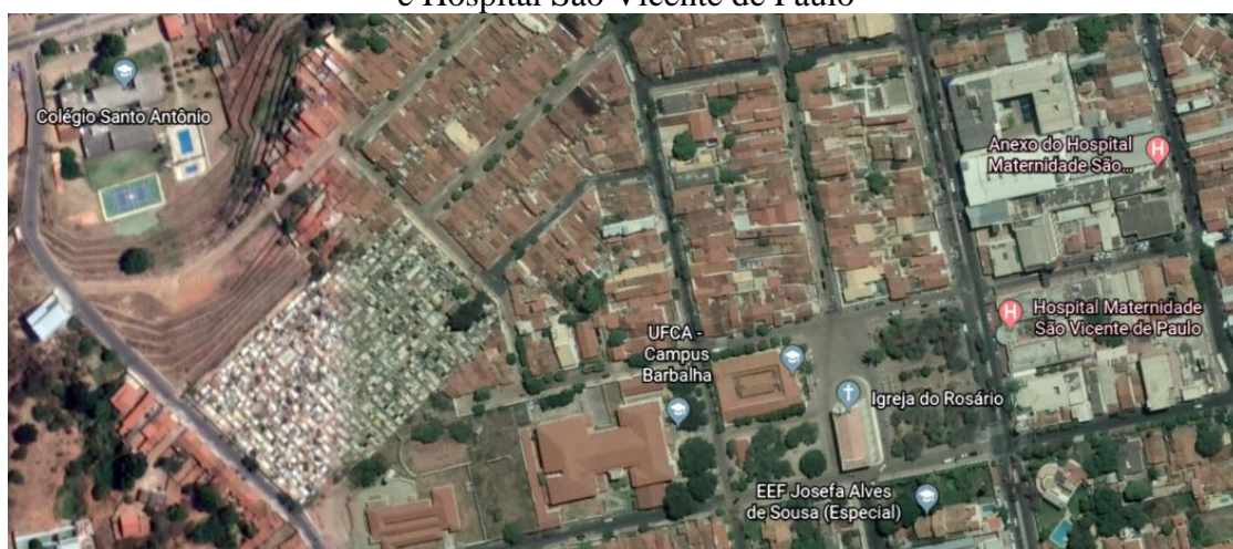
Figura 62: Plano aéreo do bairro do rosário mostrando a proximidade entre a FAMED UFCA e Hospital São Vicente de Paulo
