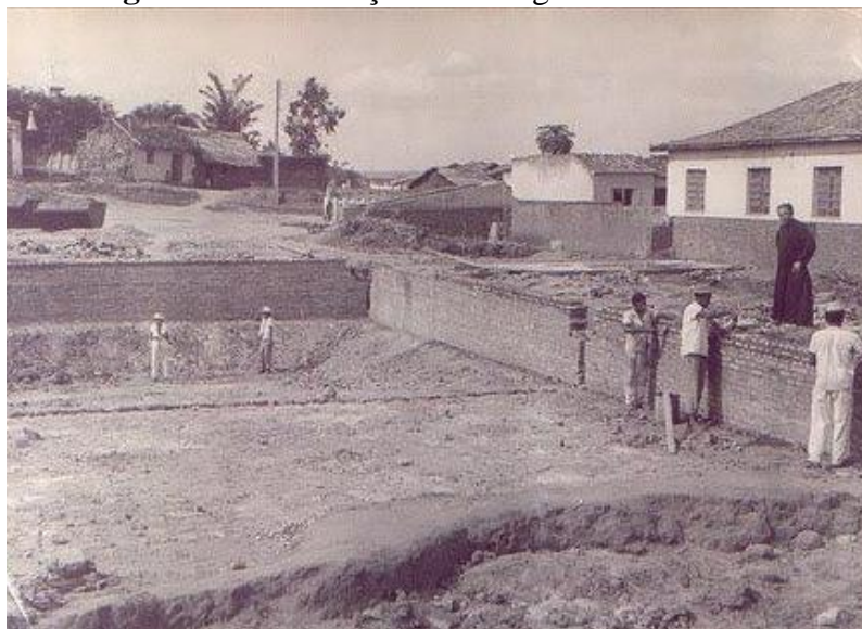
Figura 64: Construção do Colégio Santo Antônio
