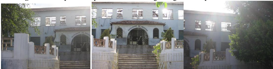
Figura 66: Aspecto do prédio ao ser entregue legalmente para a Faculdade
