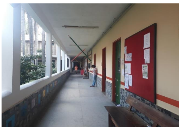
Corredor da Pedagogia
