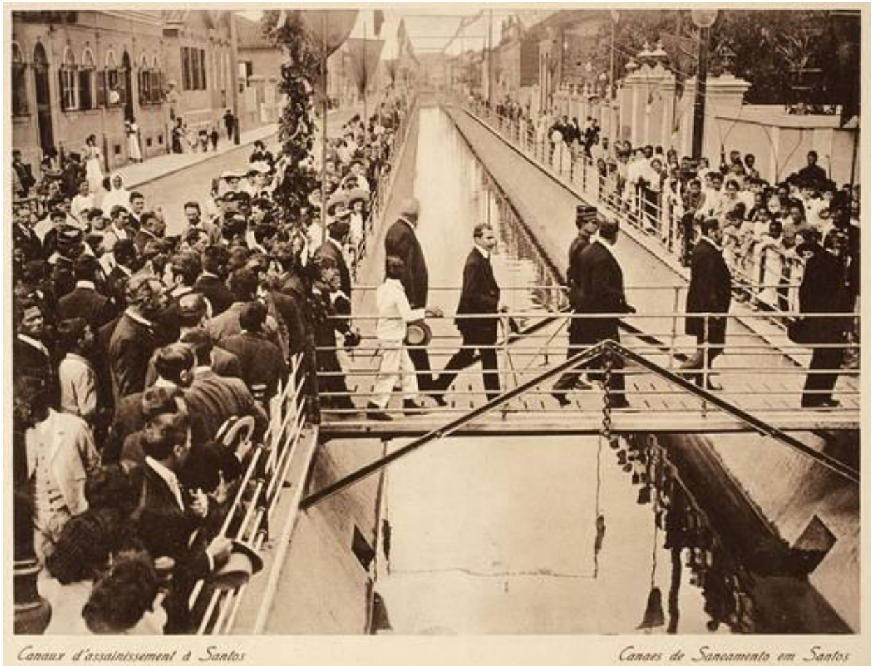
Figura 16-Inauguração do Canal da Rua Rangel Pestana-agosto 1907. Fonte: Álbum Canais de Drenagem Superficial -1906-07
