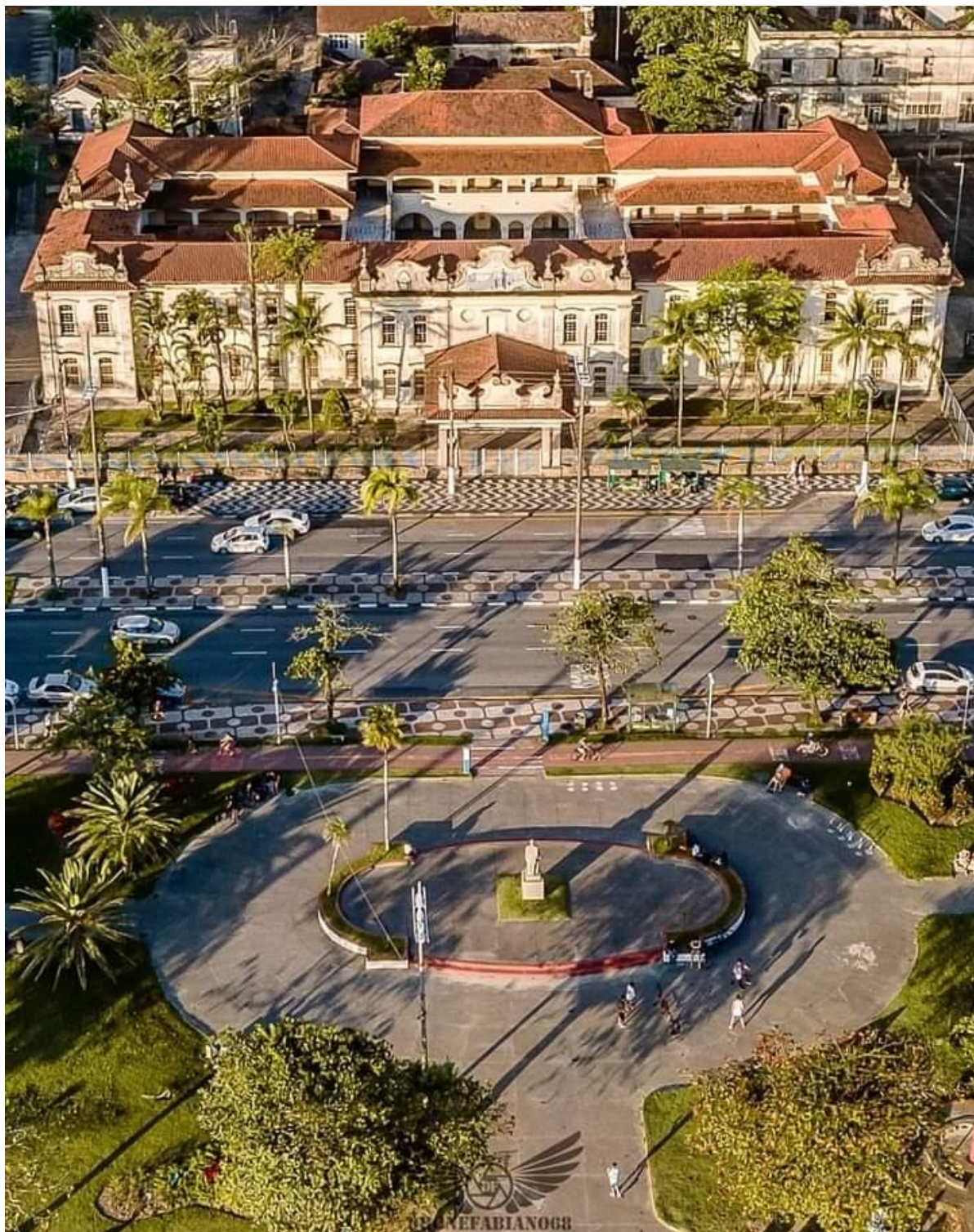
Figura 81-Foto atual do Edifício do Instituto Dona Escolástica Rosa. Créditos: @dronefabiano68
