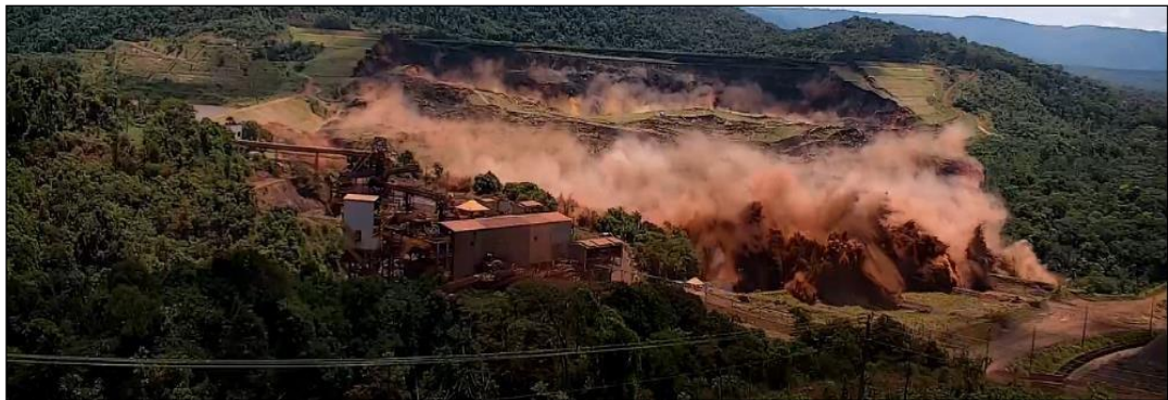
Imagem 7: Vista Frontal do início do rompimento da Barragem 1 - Mina Córrego do Feijão, Complexo Paraopeba - VALE S. A., Brumadinho/MG
