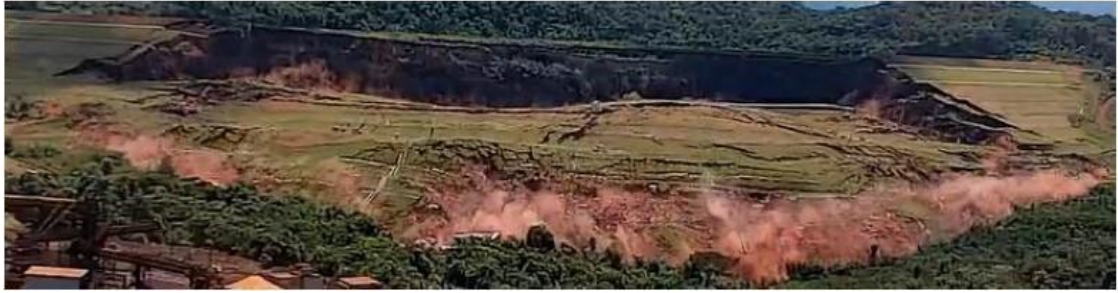
Imagem 6: Vista Frontal do início do rompimento da Barragem 1 - Mina Córrego do Feijão, Complexo Paraopeba - VALE S. A., Brumadinho/MG.
