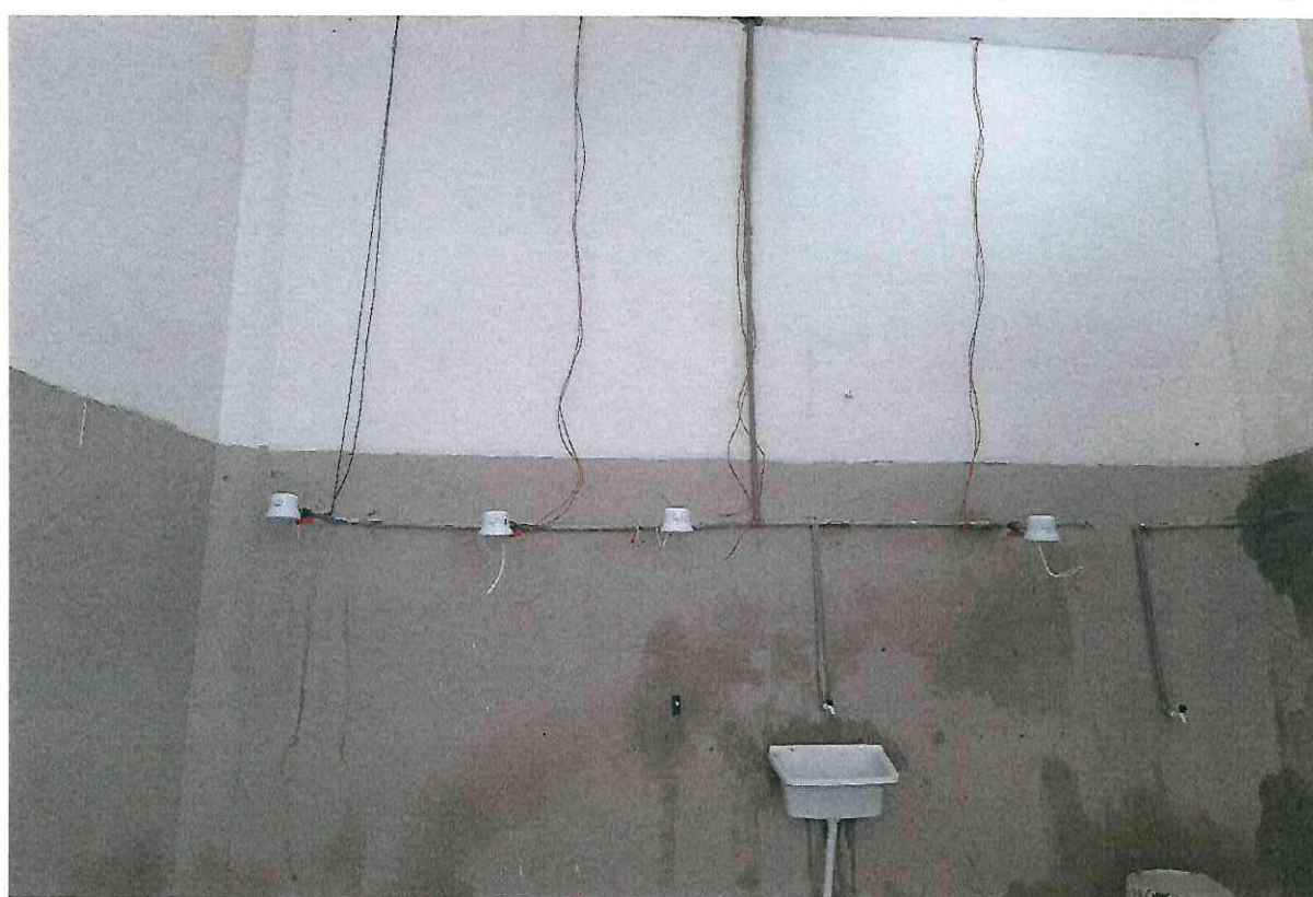
Instalação 4 chuveiros quentes no Raio 02
