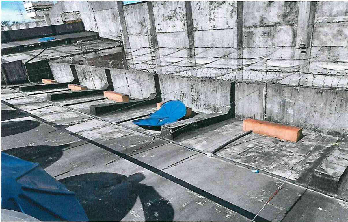
Tampas arrancadas pelo vento que são recolocadas pelo setor de manutenção
