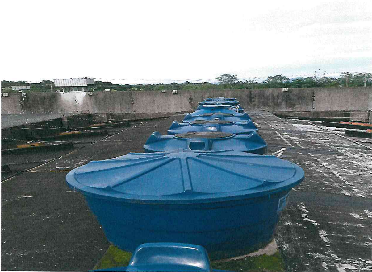
Tampas arrancadas pelo vento que são recolocadas pelo setor de manutenção
