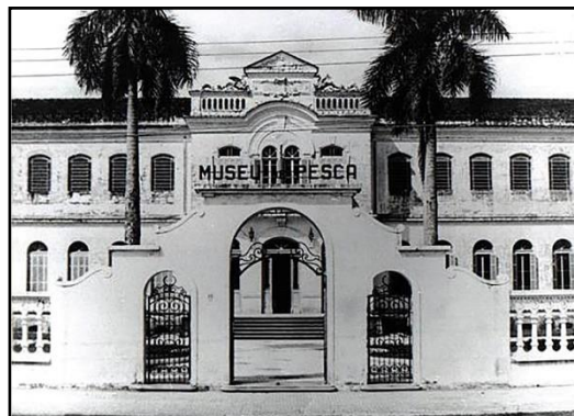
Figura 20 Prédio do Museu de Pesca por volta de 1945, antes de sua restauração. Detalhe: vitrões de ferro ainda substituíam as originais venezianas (superiores) de madeira. Fonte: Museu do Instituto de Pesca
