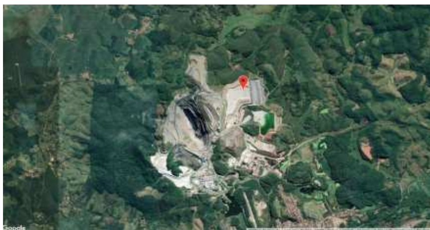
Imagem 5: Barragem B2/Cajati. Fonte: ANM
