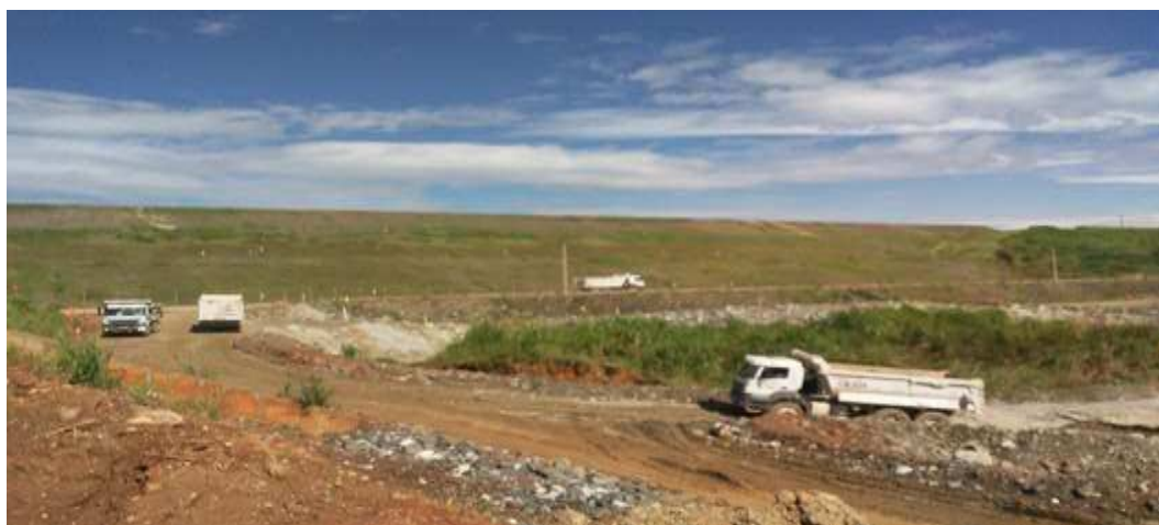
Imagem 7: Trafego de caminhões em estrada de acesso aos Bairros próximos ao Complexo Mineroquímico em Cajati. Imagem da autora.
