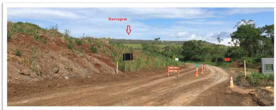
Imagem 4 – Estrada de acesso aos Bairros próximos ao Complexo Minerquímico. em Cajati.
