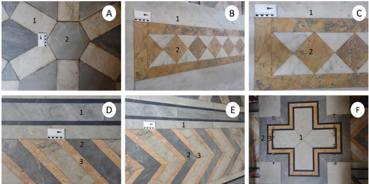
Figura 112 A, B, C, D, E e F – Litologias identificadas nos pisos do elemento de geodiversidade Igreja Nossa Senhora do Rosário.
