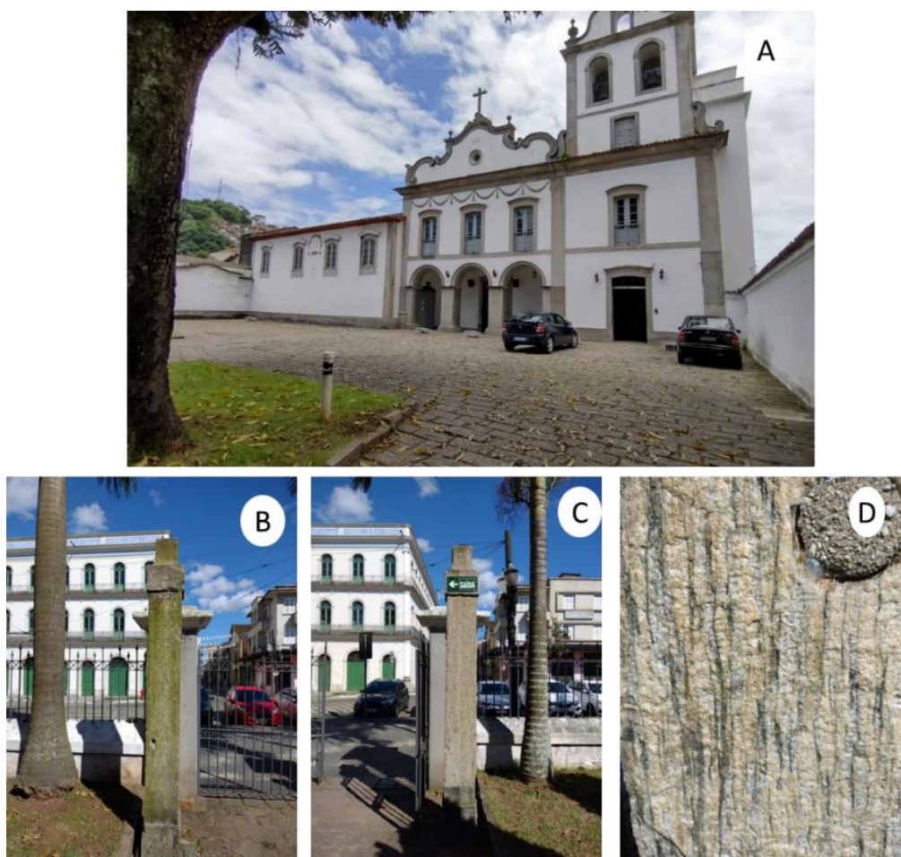
105 A – Vista geral do Santuário do Valongo; 105 B e 105 C – Colunas em gnaiss em frente à porta da grade de ferro do limite do imóvel; 105 D – Gnaiss fortemente orientado das colunas à frente da grade de ferro do limite do imóvel.
