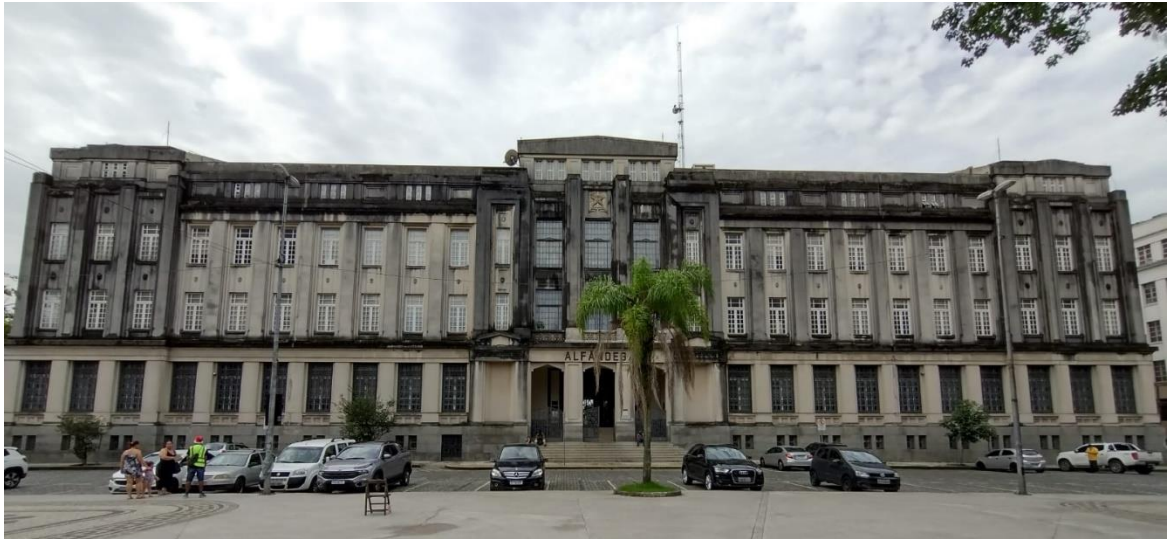
Figura 77 – Vista frontal do prédio da Alfândega.
