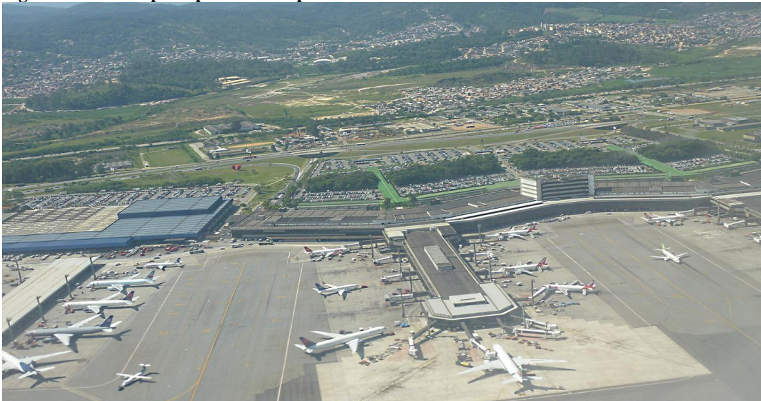
Figura 9 - Área de pátio/pista do aeroporto internacional de Guarulhos.
