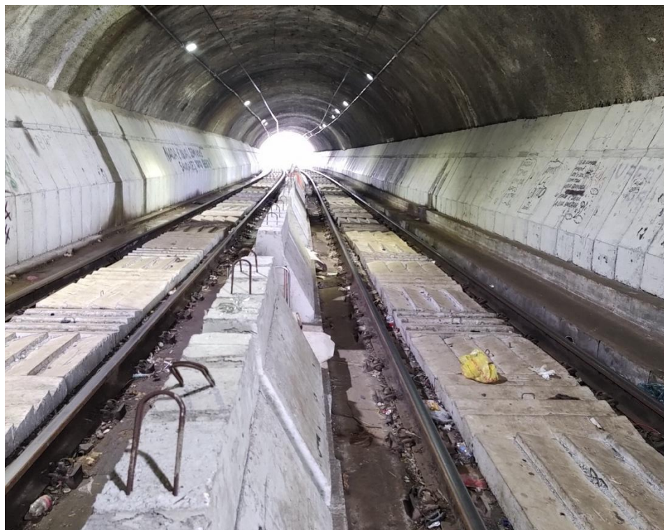
Imagem 16: Túnel com as 710 placas de concreto nas laterais, e em parte do passeio central. Custo: R$ 931.351,49
