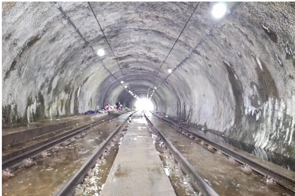
Imagem 16: Túnel com as 710 placas de concreto nas laterais, e em parte do passeio central. Custo: R$ 931.351,49
