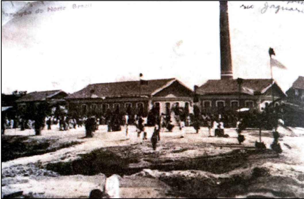
Figura 1- Casa de Máquinas e Edifícios Complementares em 1914.
