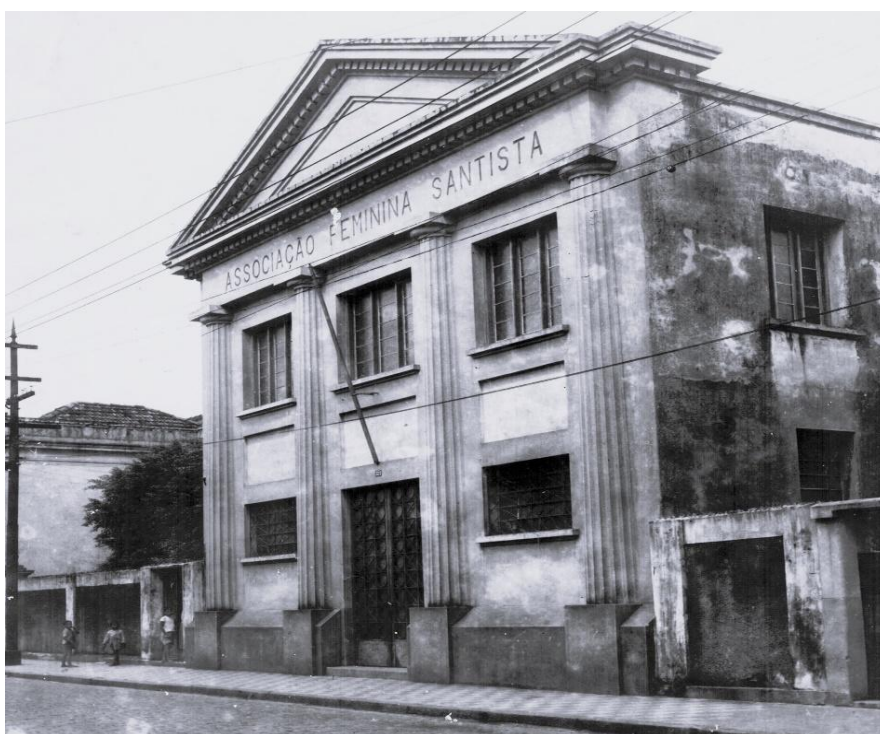
Figura 18 – Prédio Liceu e Escolas Maternais construído em 1905
