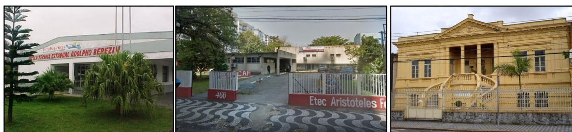
Figura 9: Três Edifícios Escolares "Atividade Profissional"
