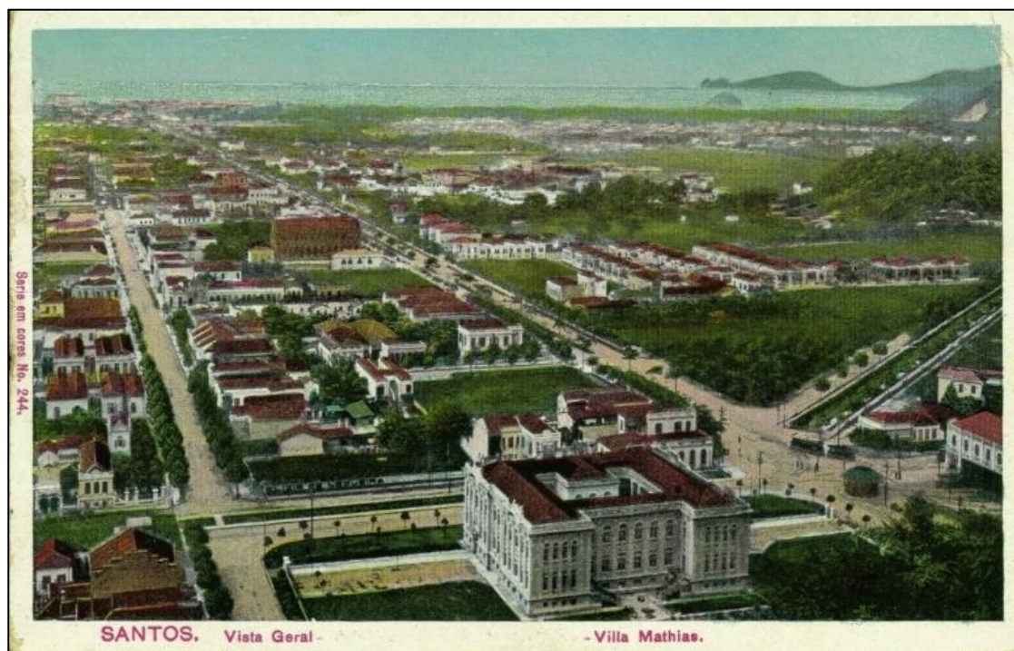
Figura 80: Ambiente Construído X Ambiente Natural: O visual do cenário construído, prevalece o mar e o horizonte natural - Monumentalidade do Edifício Escolar (primeiro plano) no Projeto Urbanístico Republicano, idealizado por políticos e elite cafeeira
