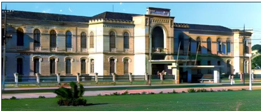
Figura 83: Edifício Escolar – Instituto Dona Escolástica Rosa
