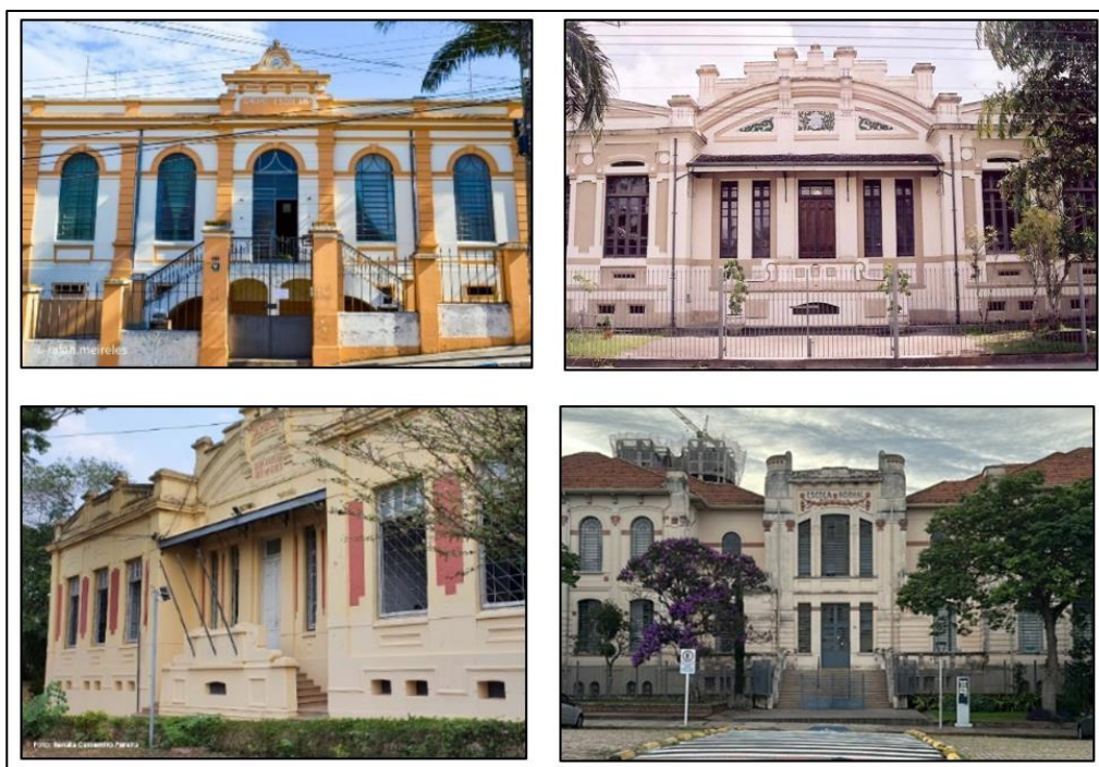
Figura 54: Edifícios Escolares – escadaria em duas partes
