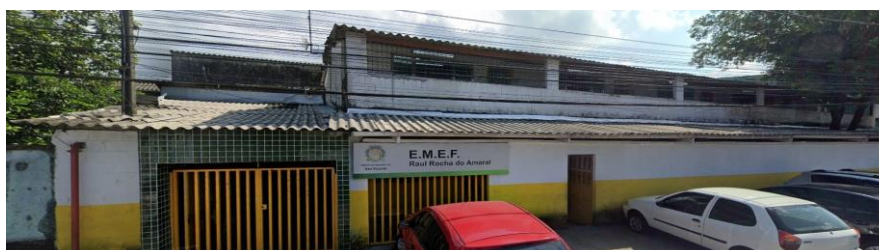
Figura 3 - Fachada da escola Raul Rocha do Amaral - Quarentenário/ SV
