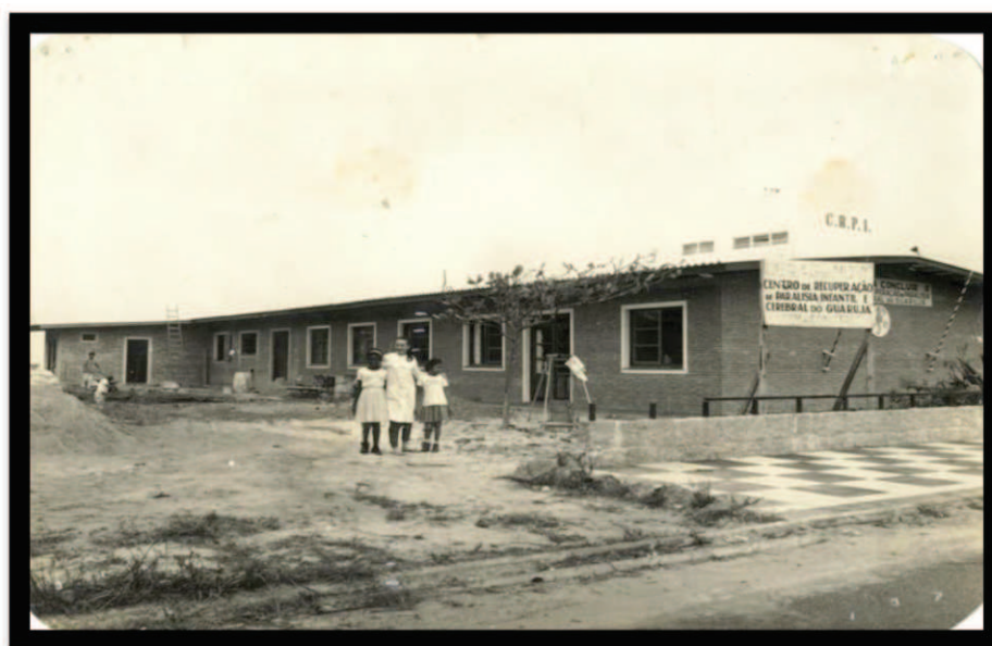
Figura V – CRPI em construção
