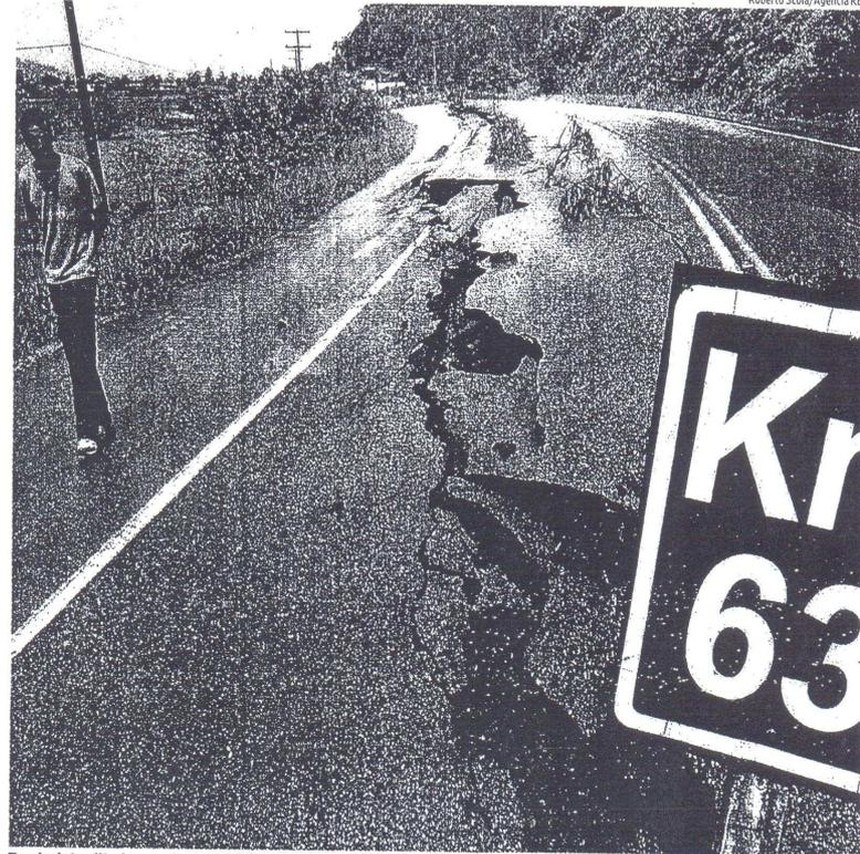
Trecho interditado na rodovia SC-411, entre os municípios de Tijucas e de Nova Trento, onde o asfalto cedeu com as inundações
