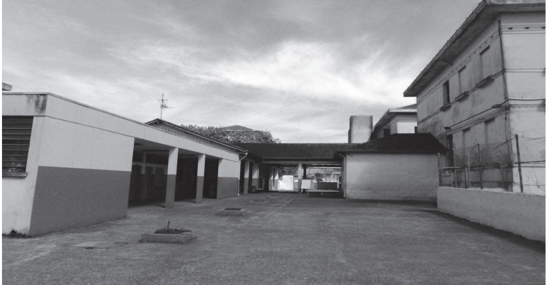
Figura 2 Construção da edícula nos fundos da Escola Visconde de São Leopoldo em 1965
